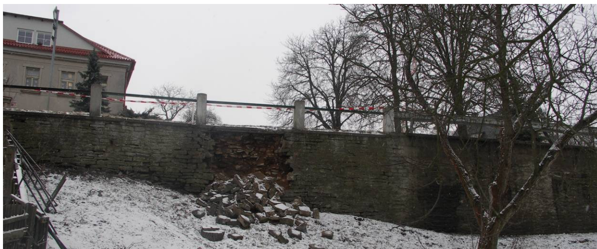
Porucha opěrné zdi
